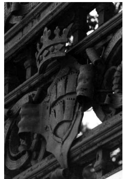
Campobasso. Particolare di cancello in ferro battuto
